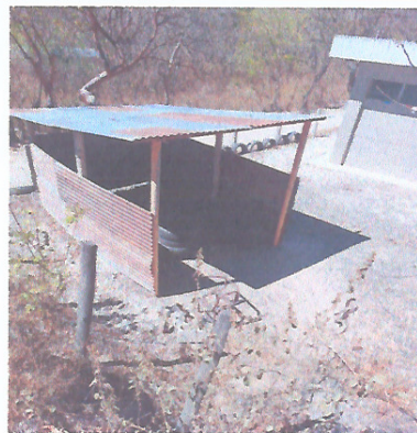
Foto 2: MEJORAMIENTO DE ESTRUCTURA DE COCINA
