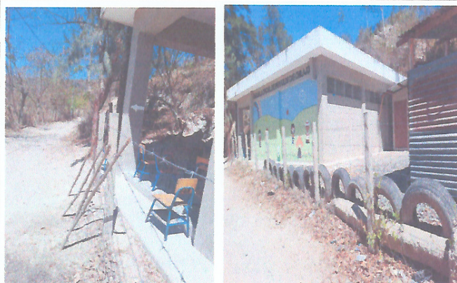
Foto 3: MEJORAMIENTO DE MURO PERIMETRAL
